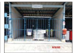
พื้นที่คอนกรีตป้องกันการรั่วซึมของสารอินทรีย์ระเหย
